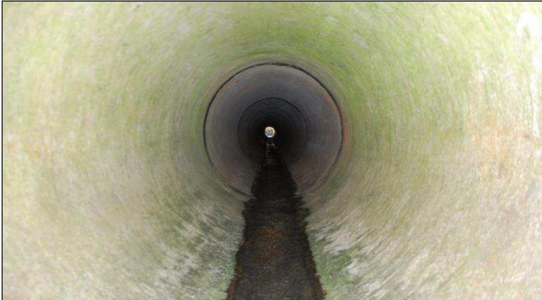
**Abbildung 7: Von Innen stellt der Durchlass eine glatte Röhre dar**
