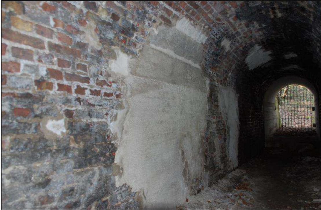
**Abbildung 14: Innenansicht des Tunnels mit frisch verputztem Teilbereich.**
